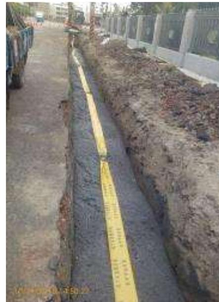
五權南路兩側人行道下設置共同管溝供給管約900m，納入弱電纜線如台電低壓線、路燈線、有線電視線及號誌線等，統一設置手孔，達到孔蓋減量目標。共同管溝供給管建置後可減少日後重複挖掘道路及人行道，維持整體道路及人行道平整度。
