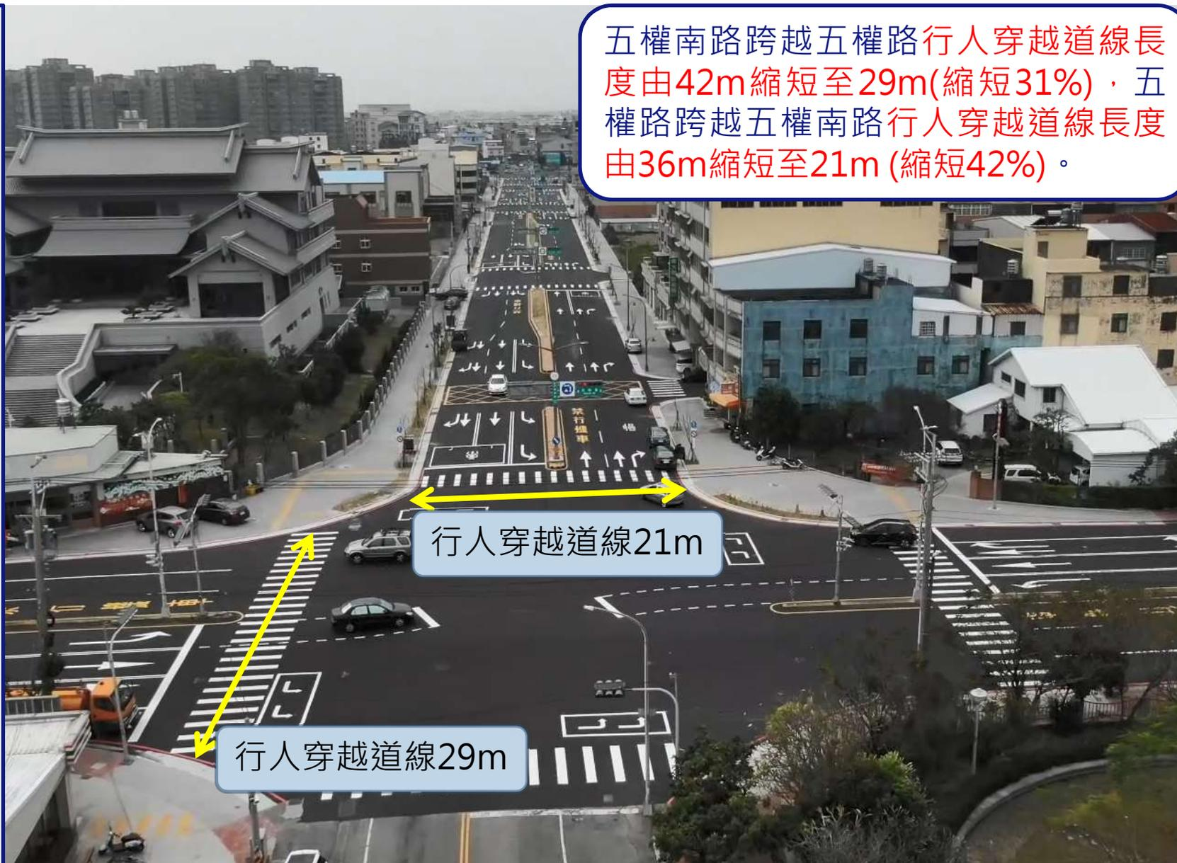
五權南路跨越五權路行人穿越道線長度由42m縮短至29m(縮短31%)，五權路跨越五權南路行人穿越道線長度由36m縮短至21m(縮短42%)。
