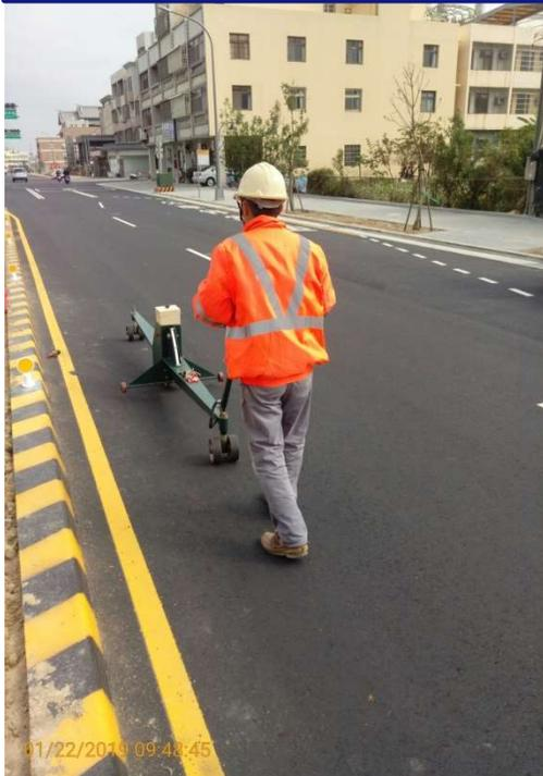
五權南路為都市計畫30m道路，雙向四車道，總長470m，因各管線單位重複挖掘及修補，導致原有路面產生破損、下陷、裂縫等。經本案重新整建後，路平改善約14,790m<sup>2</sup>及劃設抗滑型標線約1,384m<sup>2</sup>，道路及人行道平整度符合規定，大幅改善道路品質水準，並增設中央分隔島提高用路人行車安全。
