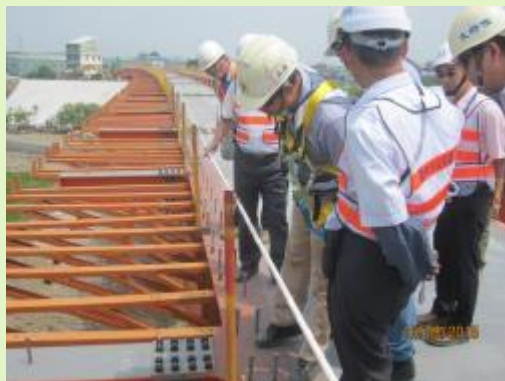
2.工程現場查核
