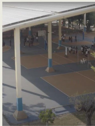
光電運動場 頂蓋鋪設浪板並加裝光電板 防水且具發電功能
