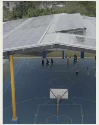
光電運動場 頂蓋鋪設浪板並加裝光電板 防水且具發電功能
