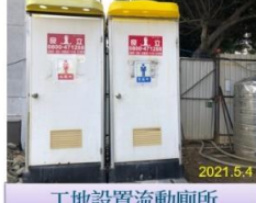
工地設置流動廁所
