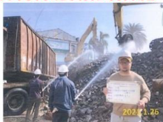
舊建物拆除灑水
